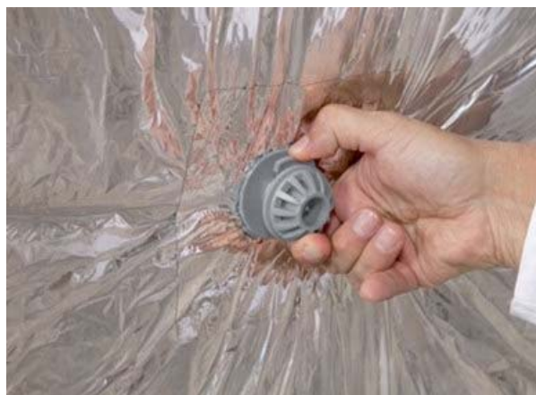
Figure 11 : Verrouillage des têtes RT Plus sur les tiges RT Plus
