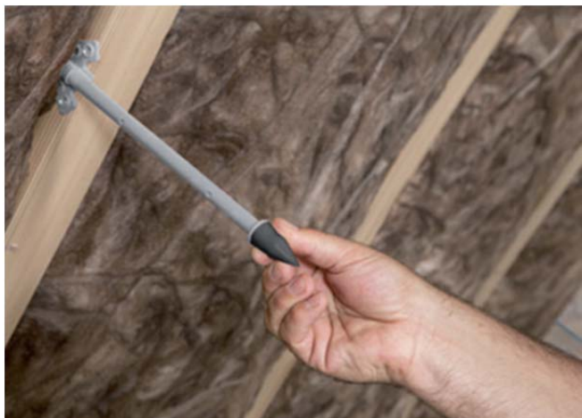
Figure 8 : Mise en place des embouts de perforation RT Plus
