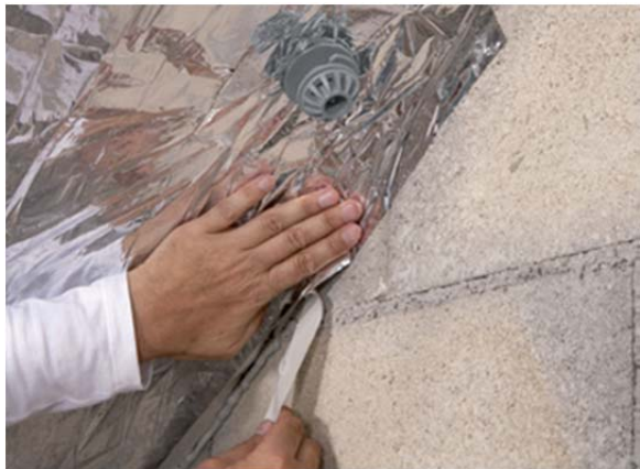
Figure 14 : L'Adhésif RT Plus ou RT Plus XL est appliqué sur le cordon de Mastic RT Plus
