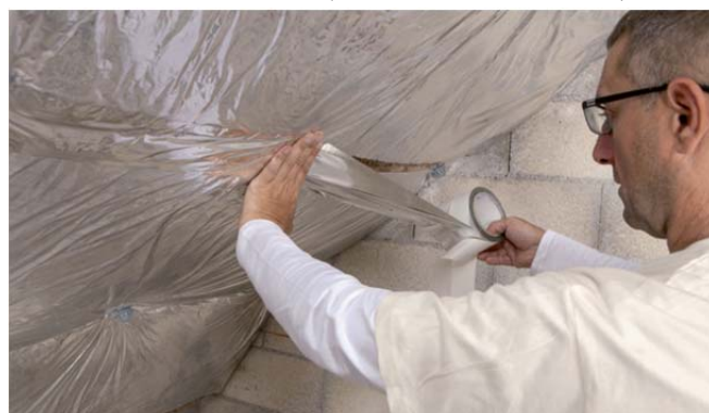
Figure 12 : Réalisation de la jonction des lés d'isolant RT Plus avec l'adhésif RT Plus
