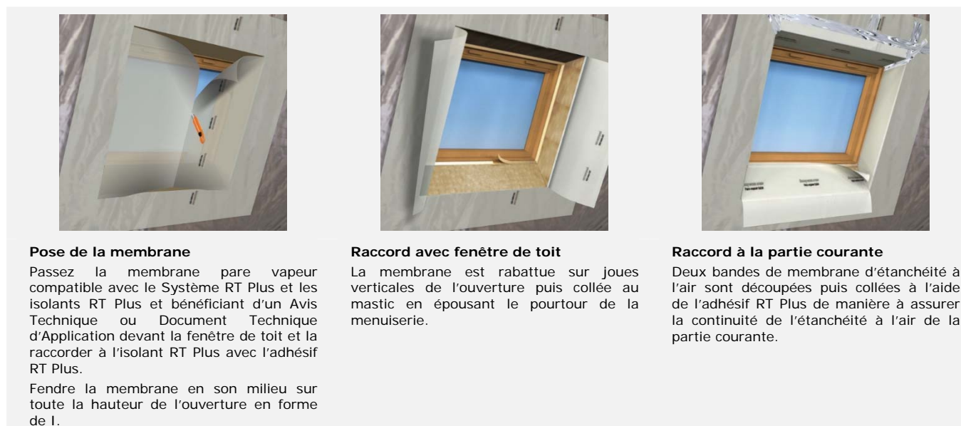
Schéma 5 : Exemple de jonction fenêtre de toit réalisée avec membranes pare vapeur (cf. § 2.45 du Dossier Technique)
