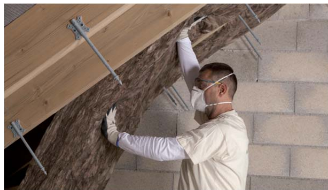
Figure 7 : Pose de la 1ère couche d'isolant entre chevrons / fermettes
