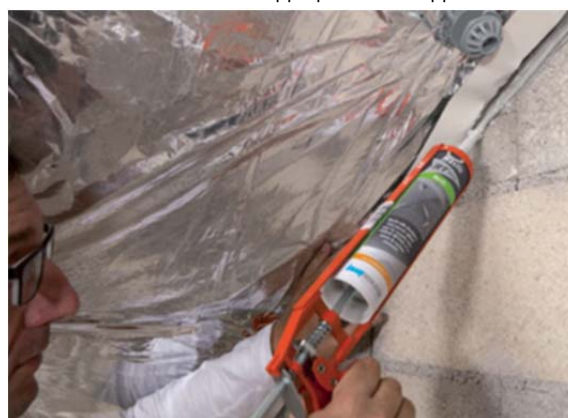
Figure 13 : Mise en œuvre du Mastic RT Plus
