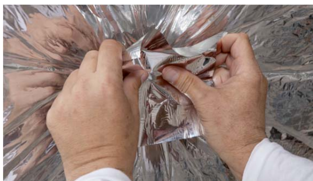
Figure 10 : Mise en place des Manchons RT Plus sur chaque Suspente RT Plus
