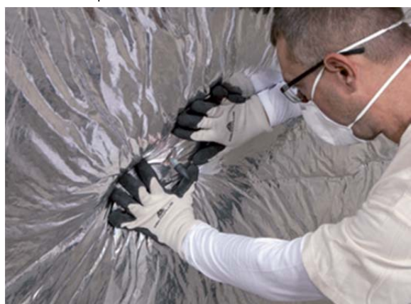
Figure 9 : Embrochage de l'isolant RT Plus (032 ou 035) sur les Suspentes RT Plus
