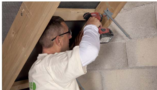
Figure 6 : Vissage des Suspentes RT Plus sur la charpente
